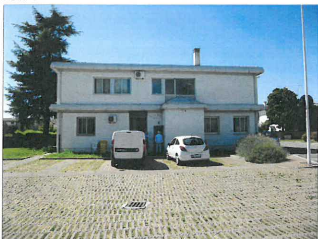
Esempi di parete esterna esistente Foto 1
