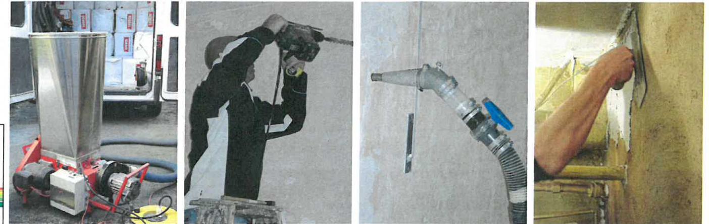
1. Preparazione macchina 2. Esecuzione fori a parete 3. Iniezione materiale isolante 4. Chiusura fori a parete
