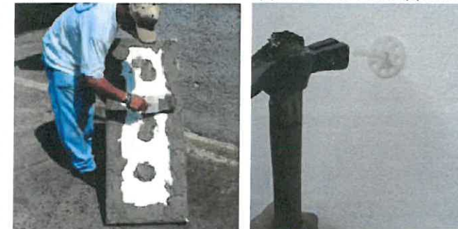
Illustrazione di alcuni elementi presenti nelle varie fasi operative dell'intervento dell'applicazione del cappotto
