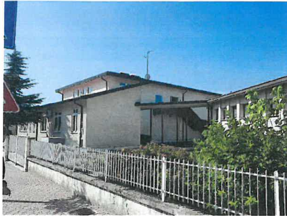
Esempi di parete esterna esistente Foto 1
