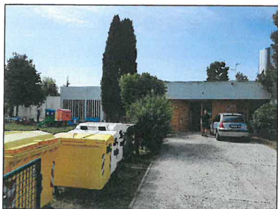
Esempi di parete esterna esistente Foto 1
