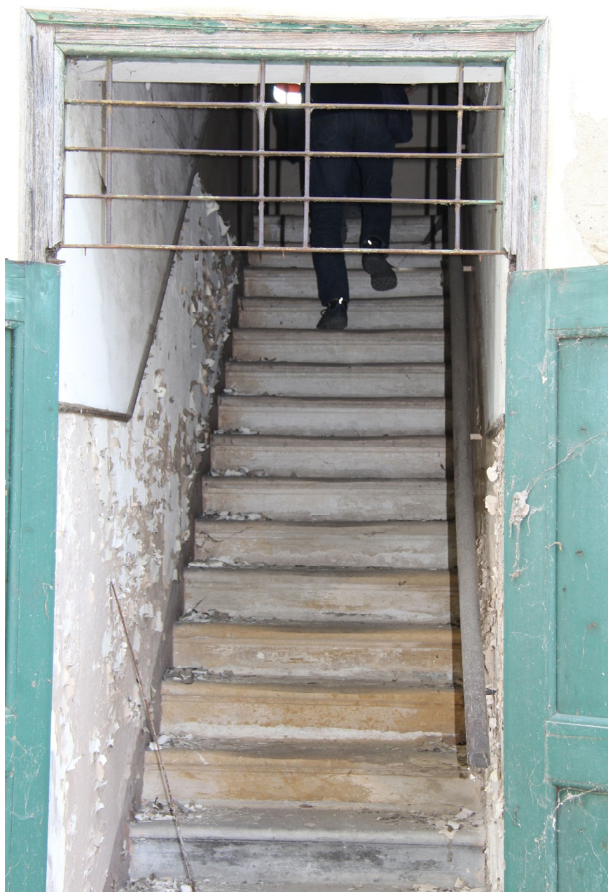
Figura 8 – veduta locale piano primo
