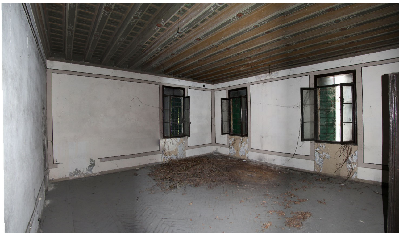
Figura 10 – veduta locale piano primo
