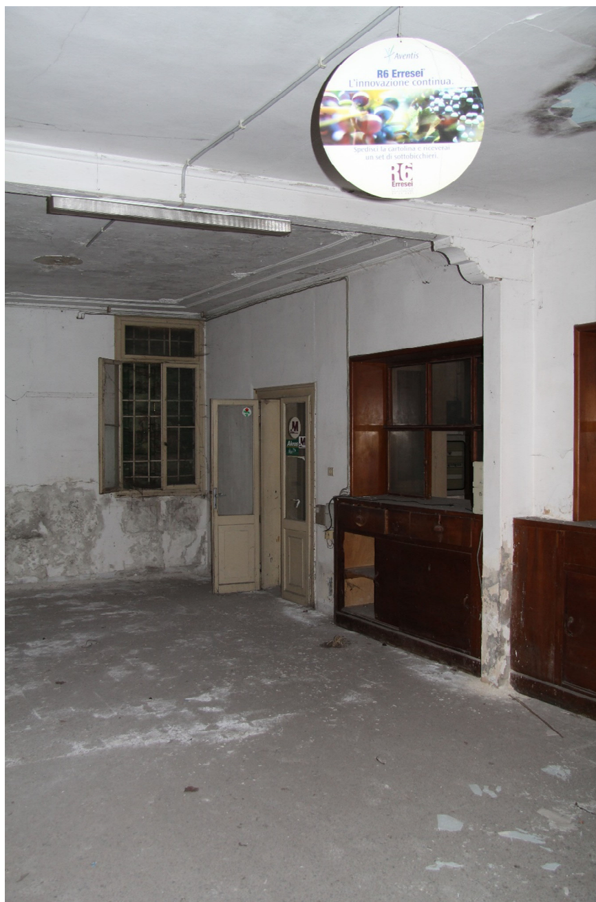
Figura 7 – veduta locale piano primo
