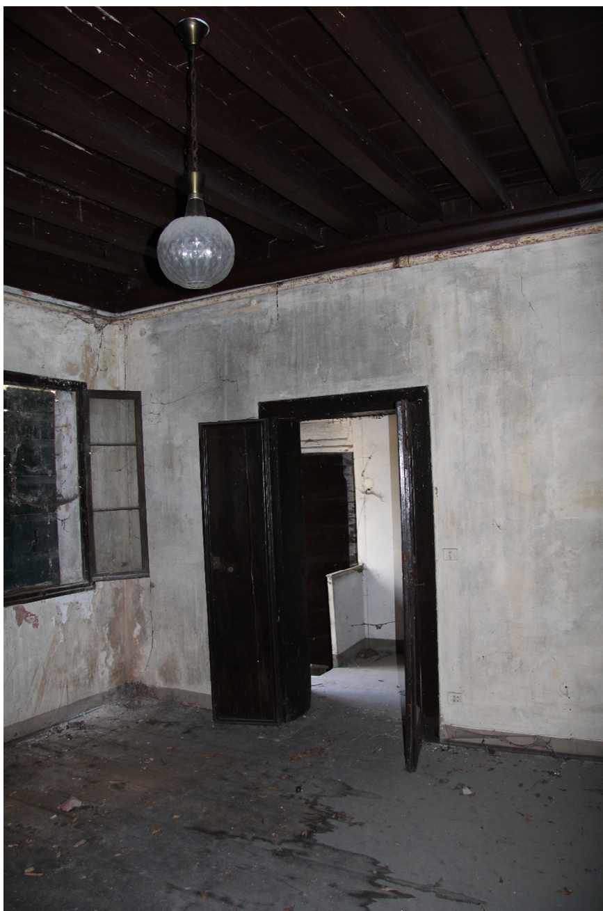
Figura 9 – veduta locale piano primo
