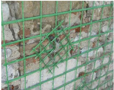
Esempio di applicazione di rete in fibra di acciaio per la realizzazione del cordolo sommitale armato
