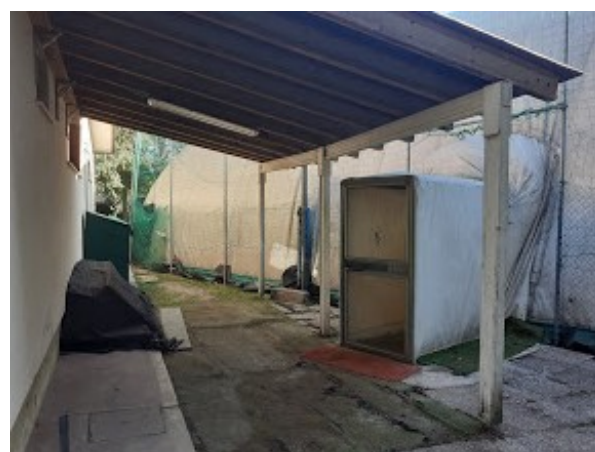
Tettoia ingresso campo tennis/calciotto
