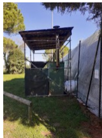
Impianto Aria e riscaldamento
