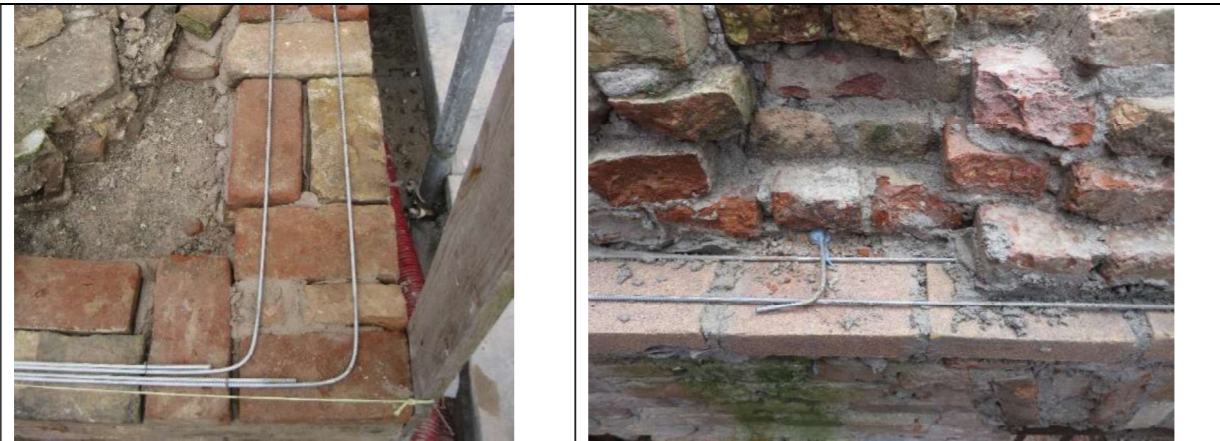
Esempi di inserimento di armature inox di piccolo diametro nei giunti di malta per la realizzazione di cordoli
