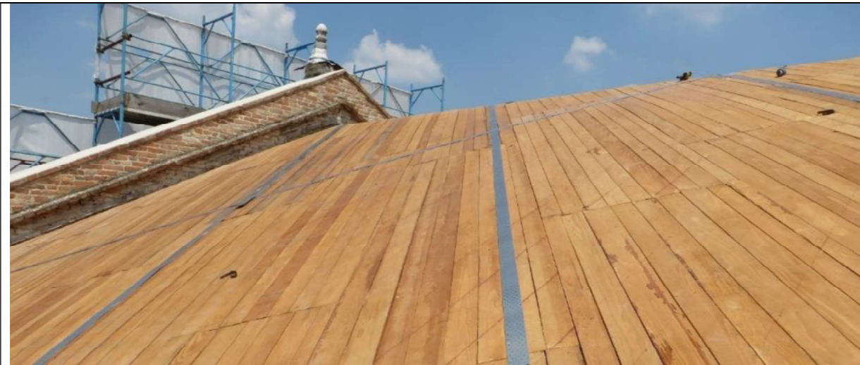
Esempio di controventamento con nastri forati in acciaio (fase di montaggio)
