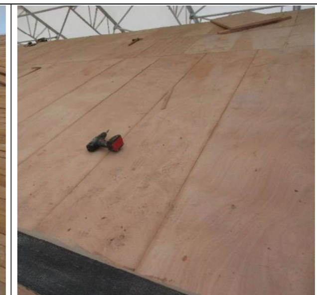
Esempio di controventamento con pannelli in multistrato
