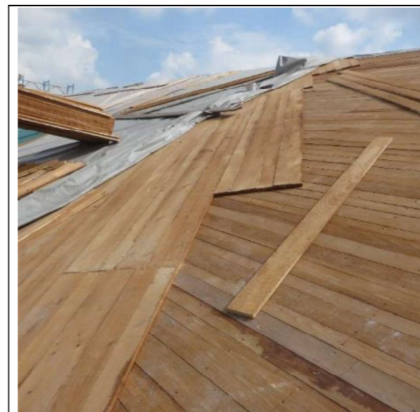
Esempio di doppio tavolato incrociato posato con giunti sfalsati
