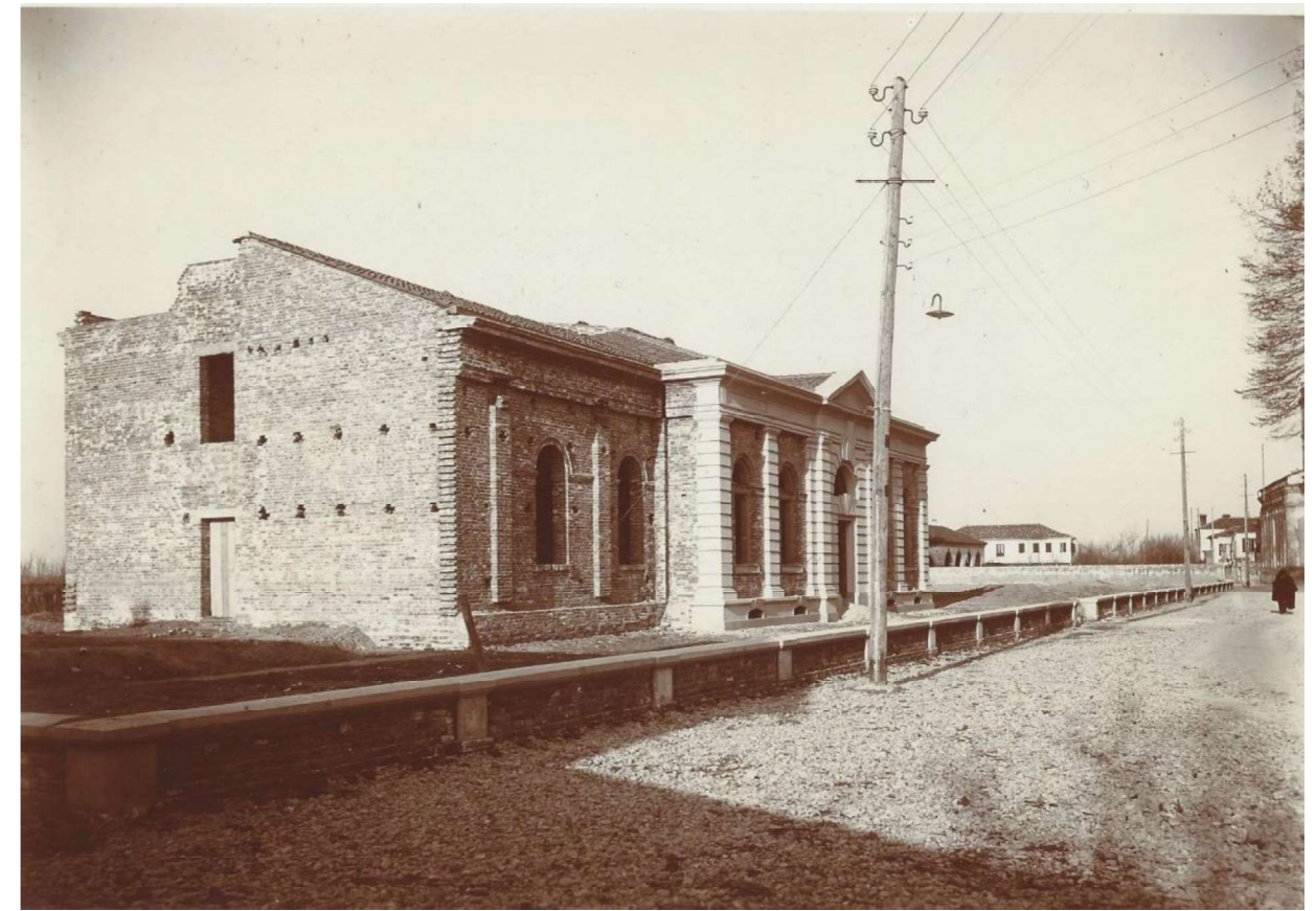
FIG. 6 - La foto mostra l'edificio a conclusione della sua 1a fase costruttiva (ca. 1914); risultano realizzati solo il corpo centrale, in aggetto rispetto al profilo della facciata, e una prima parte dell'ala ovest. L'intento di prolungarla è dimostrato dalla muratura frontale lasciata incompiuta e dai muri longitudinale predisposti così ad ammorsare l' addizione muraria in continuità. Non emerge ancora il corpo della torre, ma il suo massiccio basamento fondazionale era ovviamente già stato realizzato. Il muretto di recinzione è invece già compiuto e si sviluppa su tutta la lunghezza del lungo lotto assegnato. Non si tratta dunque di una foto di cantiere in corso, non ci sono impalcature. I lavori sono stati sospesi e il primo cantiere è stato dismesso probabilmente in attesa di nuovi finanziamenti e di un progetto suppletivo per un nuovo stralcio.
