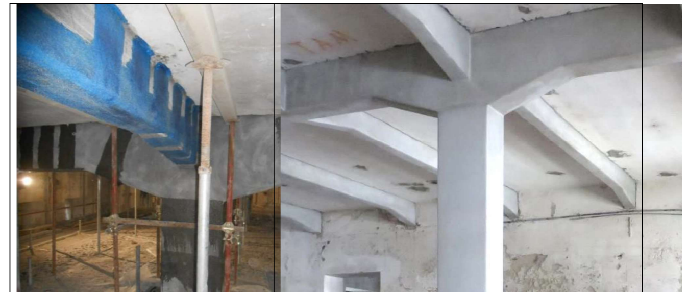
Esempio tipo di rinforzi a flessione e taglio con lamine in carbonio e fasciature con tessuto in fibra di carbonio (a dx dopo la rasatura e prima delle finitura)
